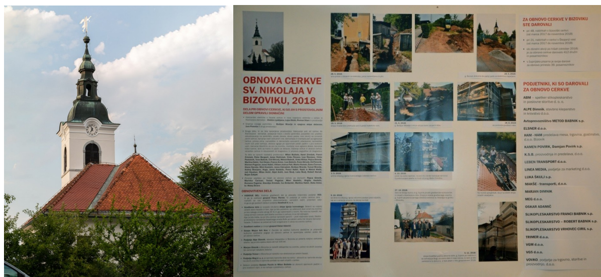
Slika 15: Obnovljena fasada in del strehe cerkve Sv. Nikolaja, Bizovik (levo). Povzetek obnove, ki je potekal septembra in oktobra 2018 (desno) (foto: T. Knapič in S. Zidar).
