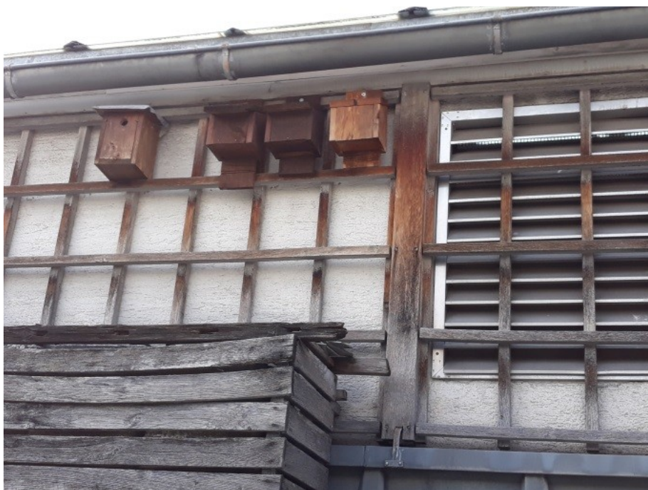
Slika 10: Netopirnice, nameščene na strehi stavbe na Prešernovi cesti (foto: T. Knapič).
