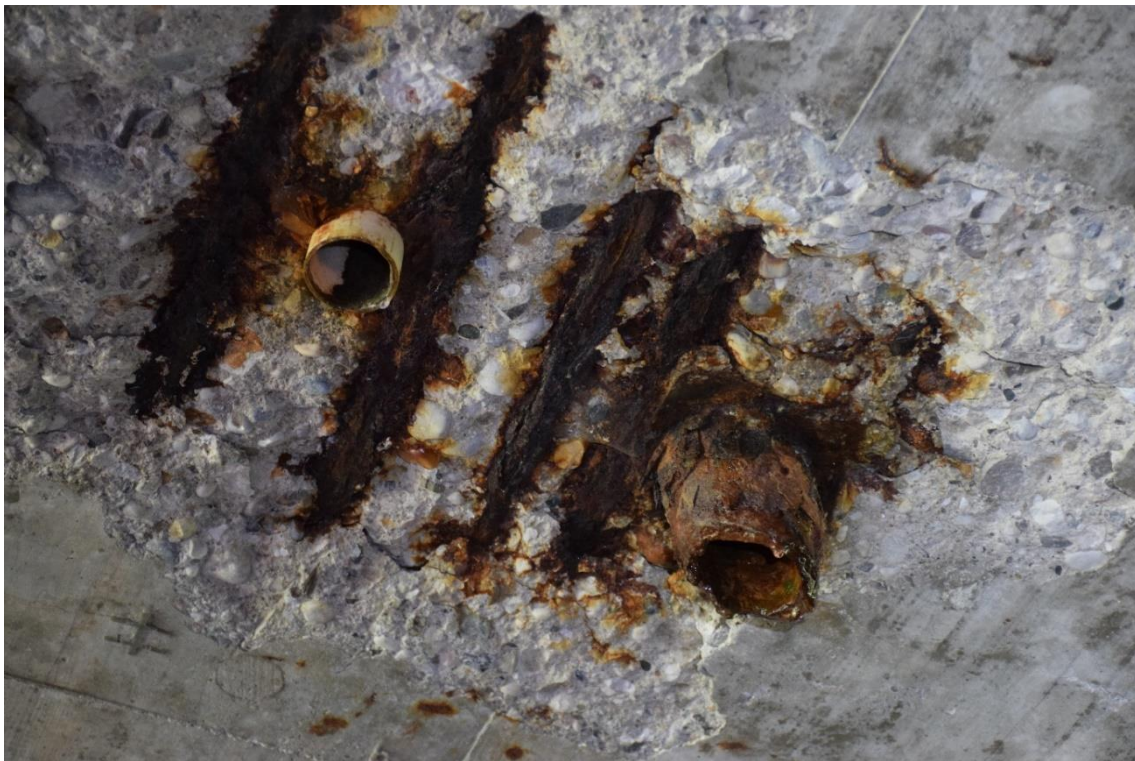
Slika 15: Pod mostom čez Gradaščico najdemo dva glavna tipa cevnih struktur, ki lahko služijo kot netopirska zatočišča – cevi z večjim premerom in, v večjem številu, cevi z manjšim premerom. (Foto: J. Gojznikar)
