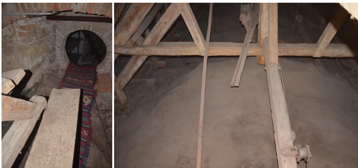
Slika 3: Stanje na podstrešju cerkve po čistilni akciji. (Foto: S. Zidar)
