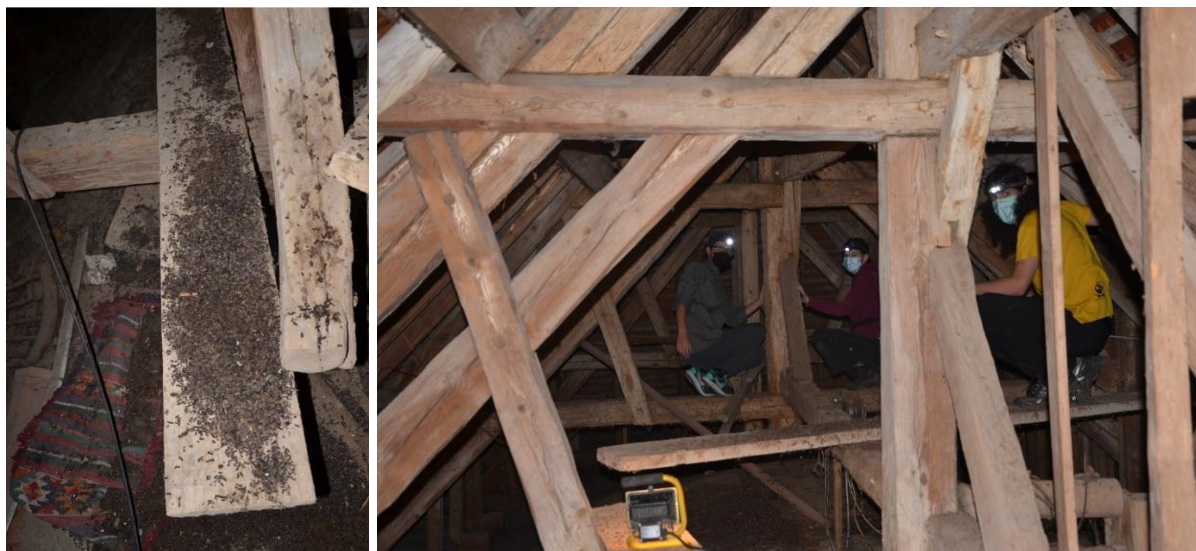
Slika 2: Stanje na podstrešju pred čiščenjem (Foto: S. Zidar)
