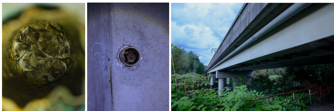
Slika 11: a) Obvodni netopir ( Myotis daubentonii ) v cevi pod mostom na Cesti Dolomitskega odreda. b) navadni/ostrouhi netopir ( M. myotis/blythii oxygnathus ) pod savskim mostom na Šmartinski cesti, c) most na Šmartinski cesti nad reko Savo. (foto: Pia Golob)
